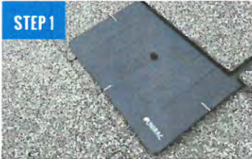
INSTALL FLASHKIT PRO FLASHING
